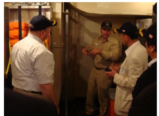
写真: 「GW」における補助ボイラーの設置してあった場所。ステニスでは補助ボイラーは使用していないので倉庫となっている。
